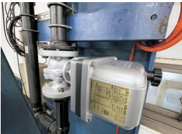
電動式 配管開閉バルブ
